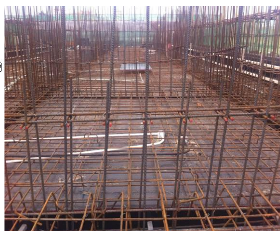
墙体水平梯子筋
