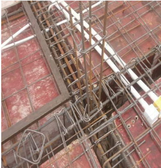
框架梁构造柱预留钢筋
