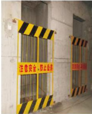
电梯井竖向防护示意图(单位:mm)
